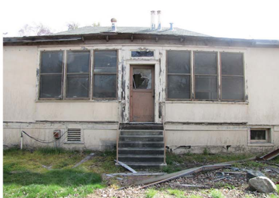
Existing Cottage (Vacant)
