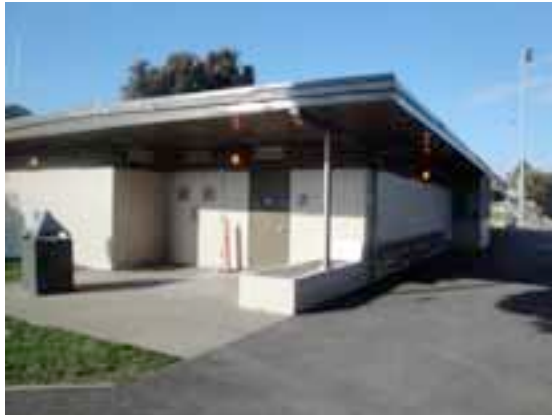
External Restrooms (N. View)
